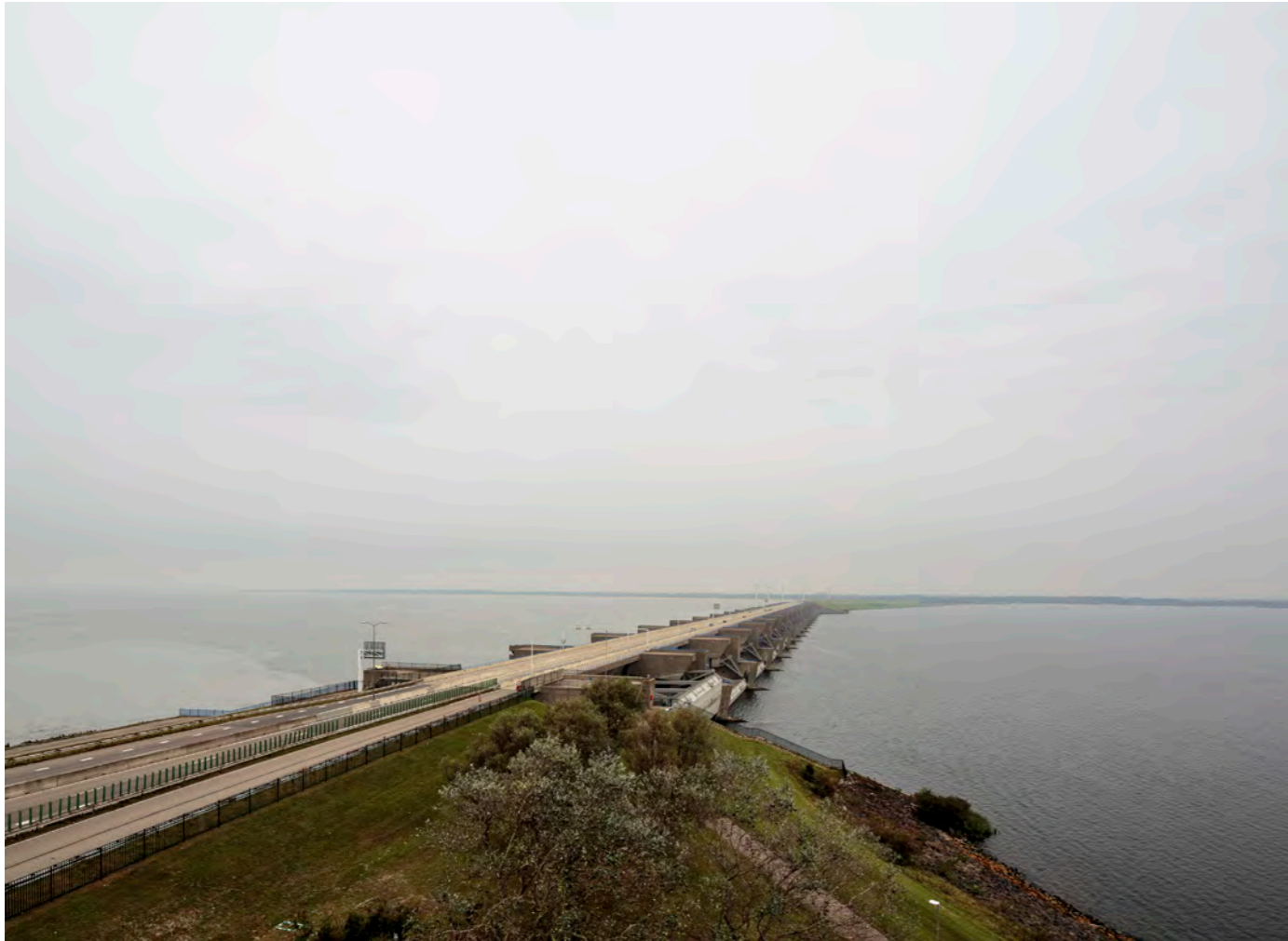
The Haringvliet Dam
